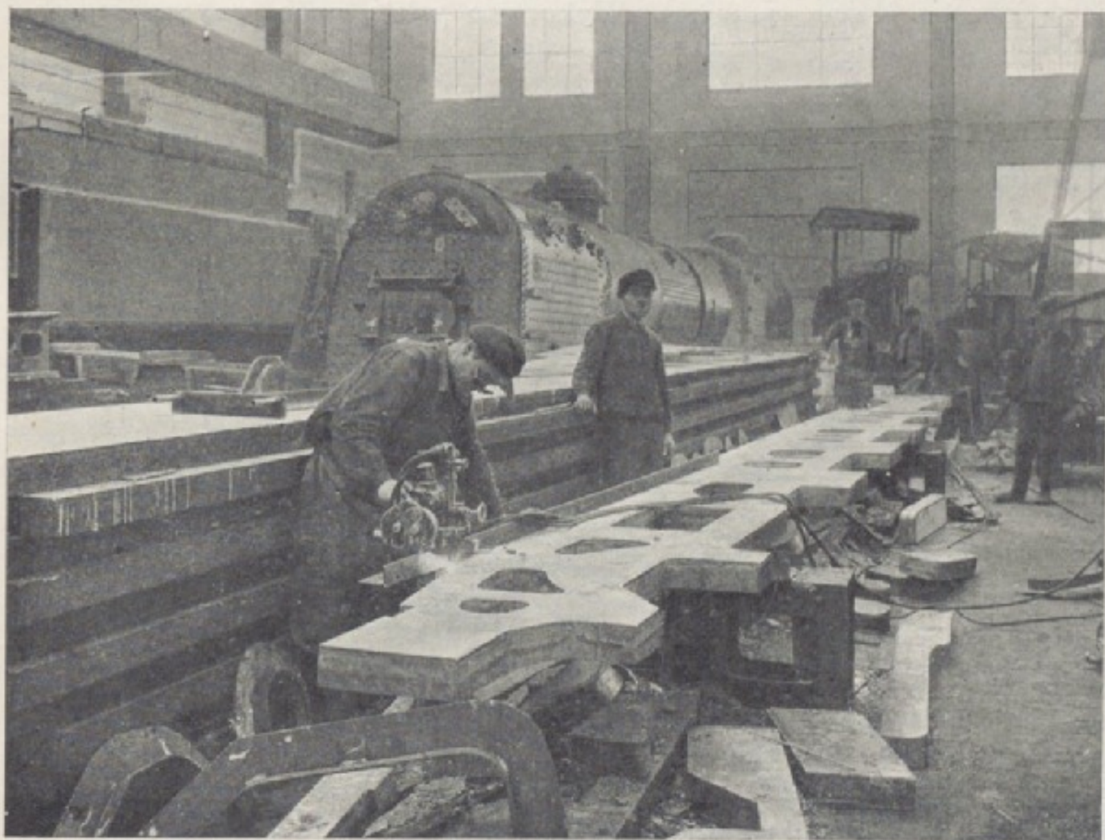
Fig. 3. Półrama parowozu bułgarskiego podczas cięcia.
