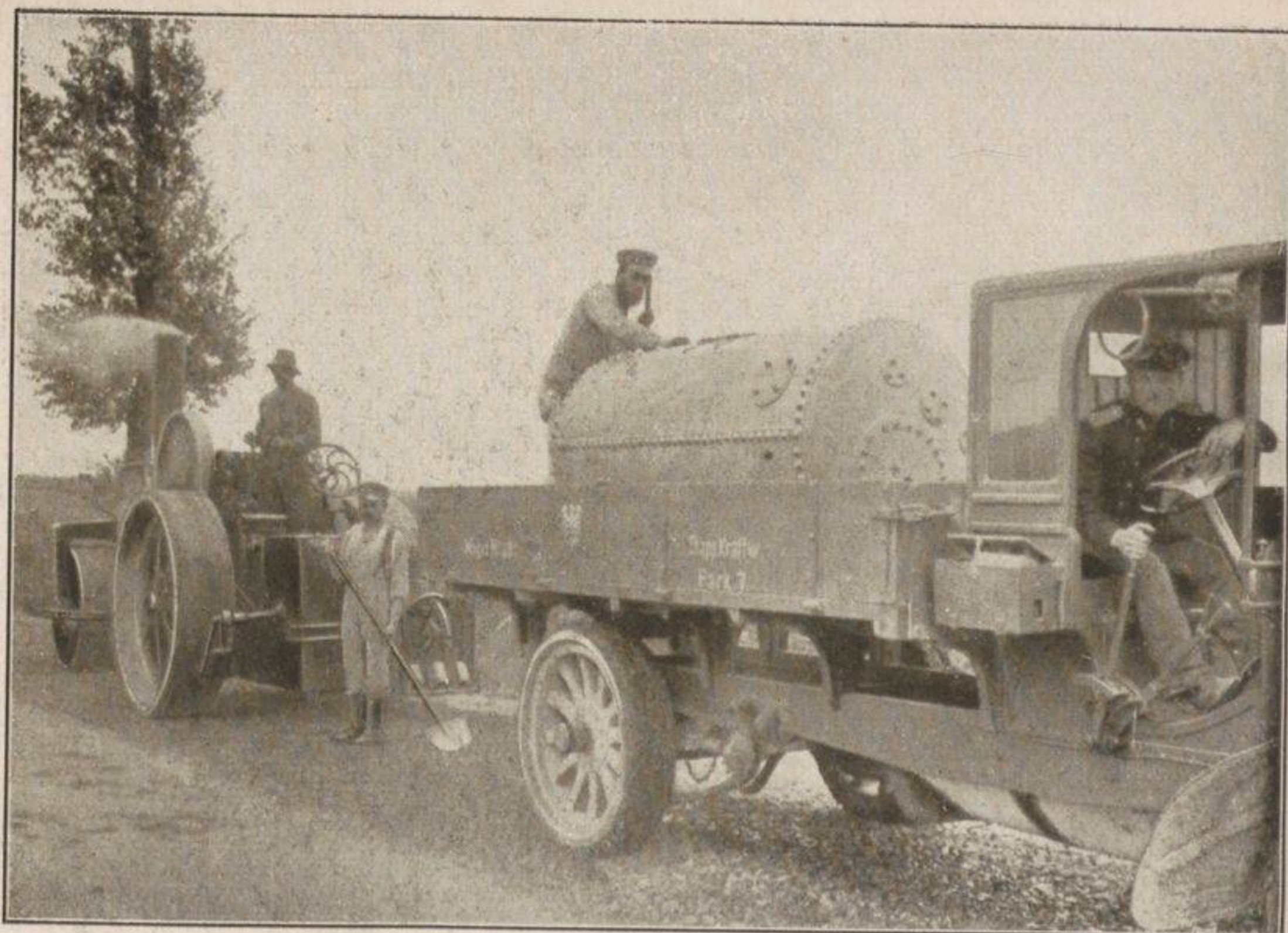
21. Ausbesserung der Landstraßen in Feindesland: Verwendung von automobilen Wassertankwagen und Dampfstraßenwalze. (Vgl. S. 20 der Beschreibung.) Phot. Leutnant d. Res. H. Frymark.
